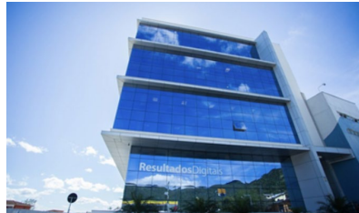
Novas instalações da RD em Florianópolis
