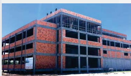
Prédio do Centro de Farmacologia em fase de construção no Sapiens Parque
